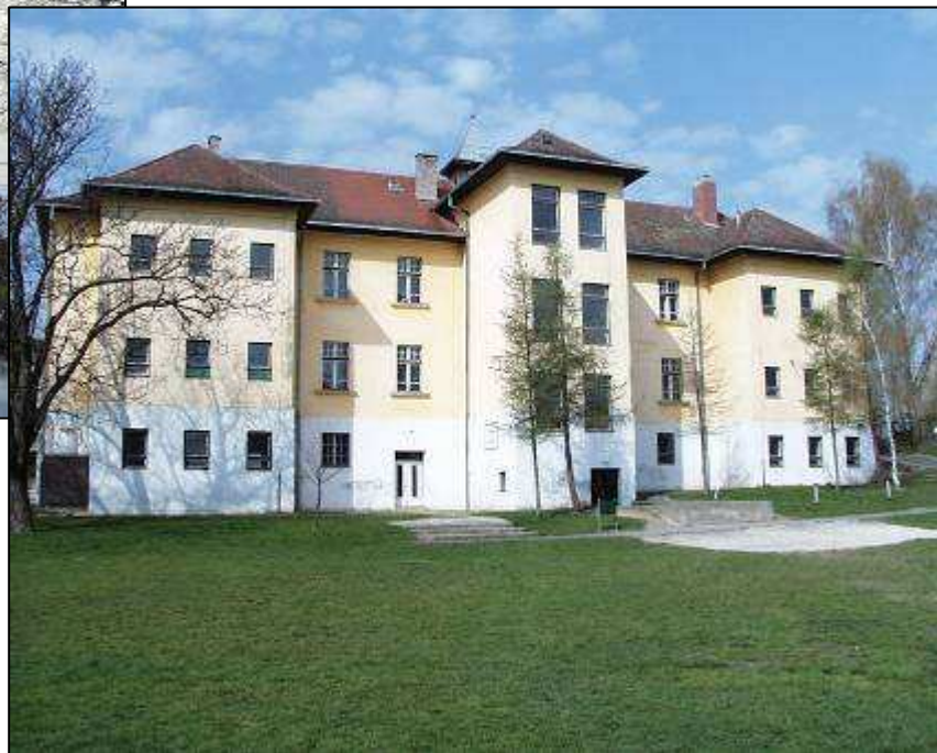
Az épület udvari képe.
